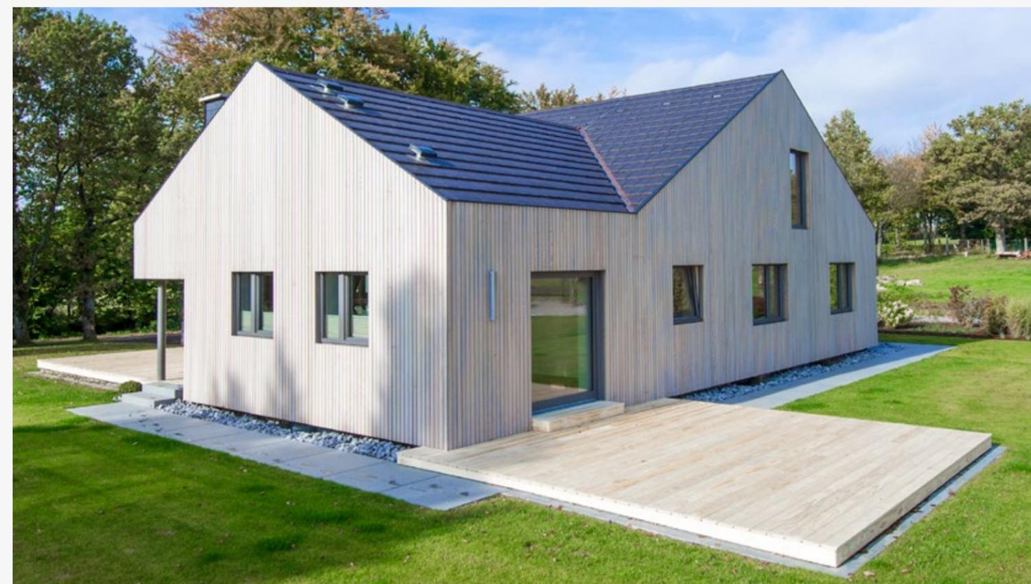
2) Le jeu entre lames préconisé à la mise en oeuvre entre lames est de 5 mm (Dossier Technique FCBA N° 2016.511.2348).
