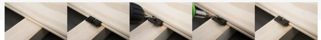
1) Un pré-perçage systématique est conseillé pour la fixation traditionnelle par vis (Dossier Technique FCBA N° 2016.511.2348) de même que pour la fixation par HardWood Clip®.
